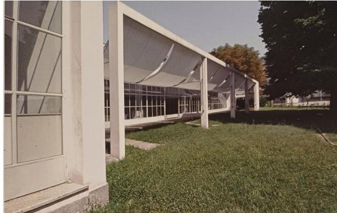
Il sistema oscurante: telaio in cls armato, meccanismi di azionamento manuale, le grandi vele
